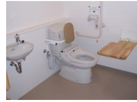
トイレは2部屋間に1箇所設置
